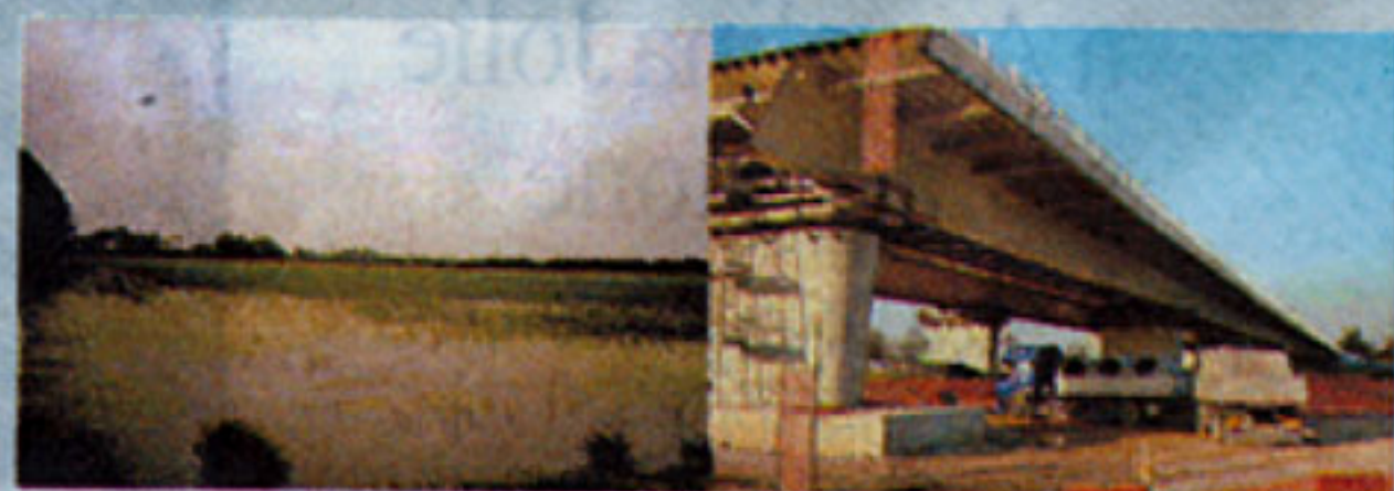
LE "RISARE" DELLE ABBADESSE A poche centinaia di metri dalle risare (risaie) delle Abbadesse, ai confini tra le province di Padova e Vicenza, si aprono gli sconquassi del cantiere dell'autostrada A 31 Valdastico
